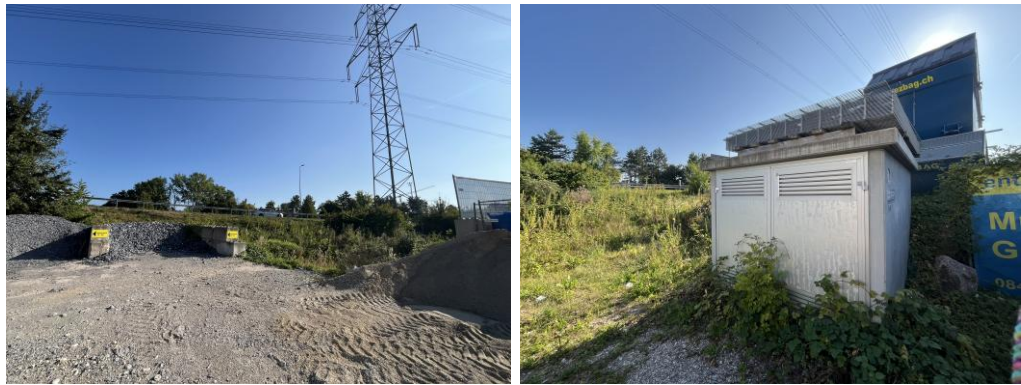
Abbildung 42: links: Hochspannungsleitung mit Mast, rechts: Transformatorenstation (Fotos: Metron)
